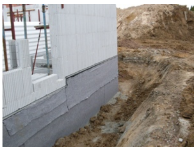
Zum Schluss wird das äußere ABG®-Schutzvlies zum Schutz der Kellerwand und der Dichtungsbahn aufgebracht
