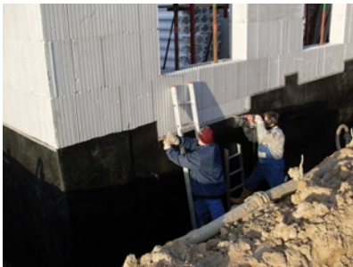
Befestigung der ABG®-Dichtungsbahn an den Styropor®-Schalungssteinen von EUROMAC2®
