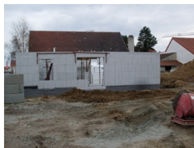
Die Gebäudehülle aus Styropor®-Schalungssteinen ist mit dem ABG®-Kellerdicht-System perfekt abgedichtet – auch beim Lastfall drückendes Wasser. Dieser Keller im rheinland-pfälzischen Lamsheim ist wärmegeklämt, wasserdicht und atmungsaktiv.
