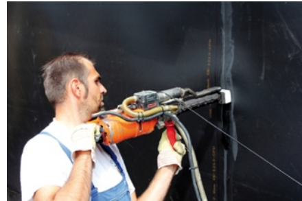
Die ABG®-Dichtungsbahn wird mit ihren überlappt verlegten Nähten thermisch verschweißt
