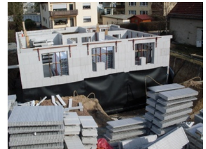
Stein auf Stein im Lego™-Prinzip werden die Styropor®-Schalungssteine auf dem ABG®-Kellerdicht-System zusammengesteckt.
