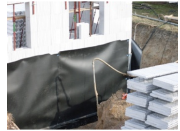
Sohle und Kellerwand werden mit einer patentierten ABG®-Dichtungsbahn aus Polyethylen hoher Dichte abgedichtet
