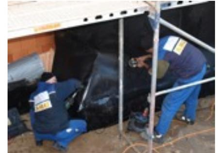
Befestigung und Glättung der ABG®-Dichtungsbahn an der Wand
