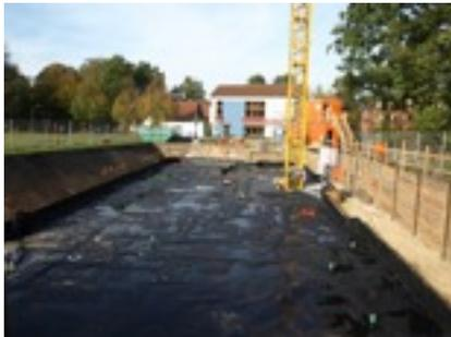
Die ABG-Dichtungsbahn ist im Sohlen- und Schalungsbereich verlegt
