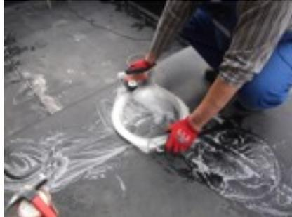
Die Nähte der ABG-Dichtungsbahn werden zu 100% mit einer Unterdruck- Saugglocke auf Dichtheit überprüft
